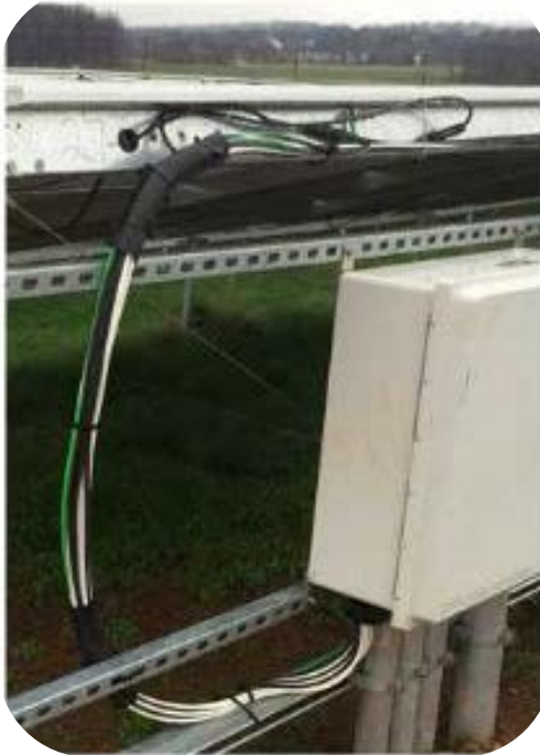
Attaches en fil de fer au support
