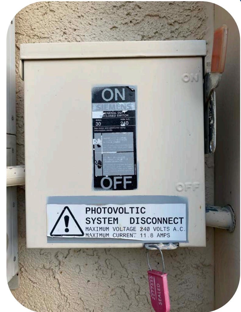
Interrupteur de déconnexion
